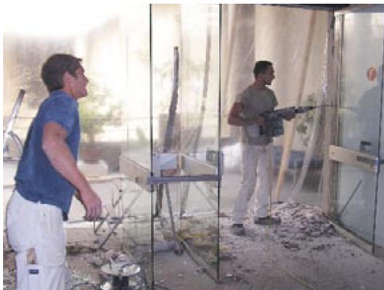
Das Hauptgebäude gleicht in den Sommersemesterferien einer grossen Baustelle. Unser Bild zeigt zum Beispiel die baulichen Vorbereitungen zum Einbau der neuen Brandschutztüren vom F-Stock in den Nordhof. (Bild res)
